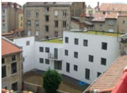
Chantier du programme Marengo à Saint-Étienne.
